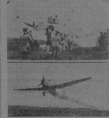
Este grabado nos muestra un aeroplano cancer siendo empleado para combatir las pestes de los campos por medio de un líquido insecticida, que va dejando caer—Arriba se ve el momento en que son llenados los tanques con dicho líquido
